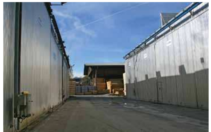
Trockenkammerallee in Kundl: Auf der rechten Seite befinden sich die neuen Mühlböck-Anlagen Typ 603
