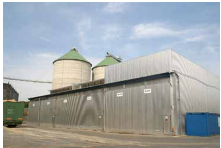
Als Besonderheit wurden die Trockenkammern mit einer Attika als zusätzliche Schallschutzmaßnahme ausgeführt
