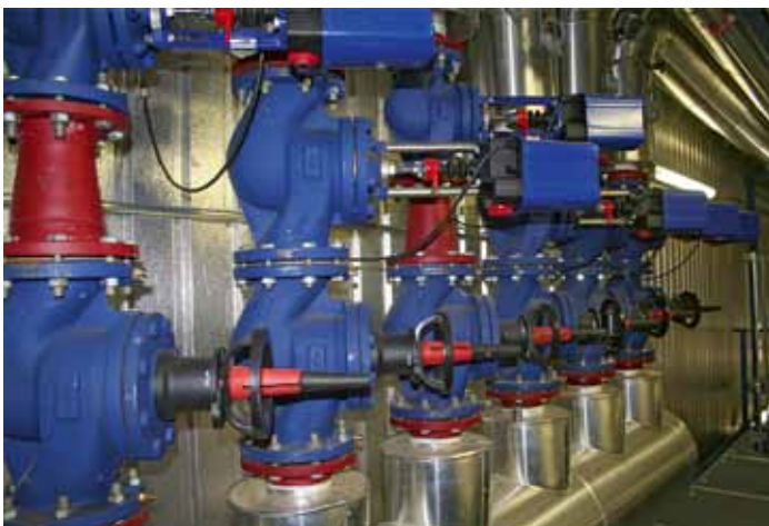
Als Komplettanbieter war Mühlböck auch für die komplette Heizungsinstallation verantwortlich
